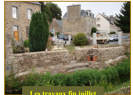
Les travaux fin juillet
