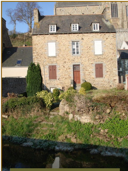
La propriété avant travaux
