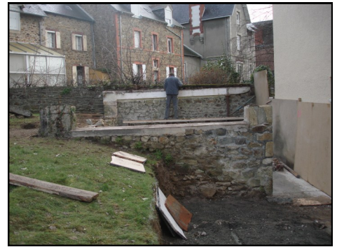
Début janvier : Les travaux de démolition en cours
